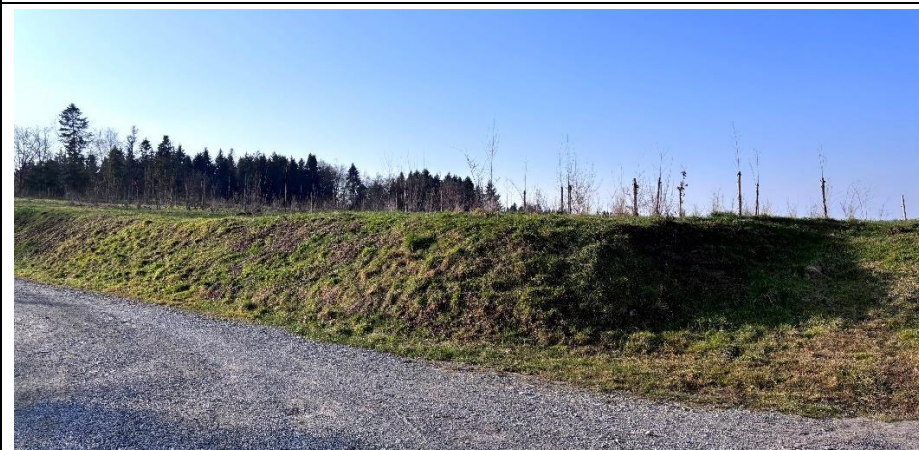
Abb. 18: Aufnahmen des Erdwalls am Scheitelpunkt zwischen D-D' und QP-1-QP-1' vor der Erweiterung IV der Kiesgrube Hof-Äbnetwald I.
